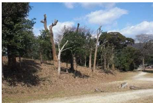
水城跡樹木整理工事の様子
