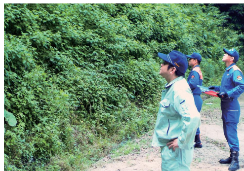
災害発生予測危険箇所調査の様子
