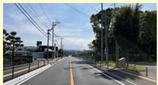
工事を完了して両側歩道になった道路
