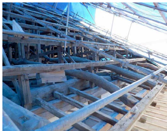
光明寺本堂 (修理中)
