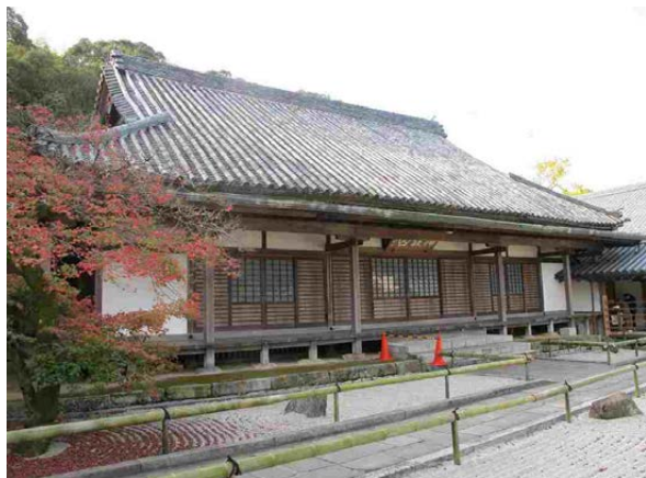
光明寺本堂 (修理前)
