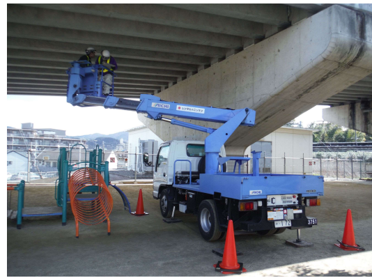
従来の点検方法（左：橋梁点検車、右：高所作業車）
