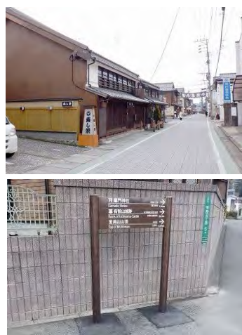
道路・水路 環境整備
