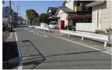
老朽化した日田街道のガードレール
