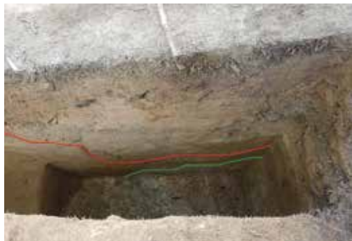
第2トレンチ東壁南側 (赤線より下層が積土、緑線が階段状の成形)
