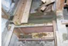
基礎の追加施工の一例
