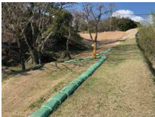
整備後の園路(土塁下部から)C地区
