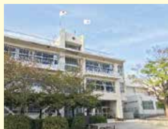
水城小学校管理棟
