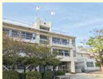
水城小学校管理棟
