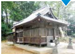
日吉神社本殿の修理
