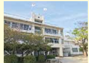
水城小学校 管理棟
