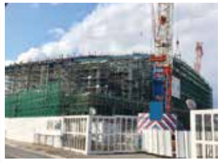
建設中の太宰府市総合体育館
