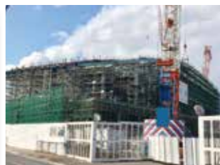
建設中の太宰府市総合体育館
