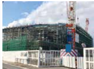
建設中の太宰府市総合体育館
