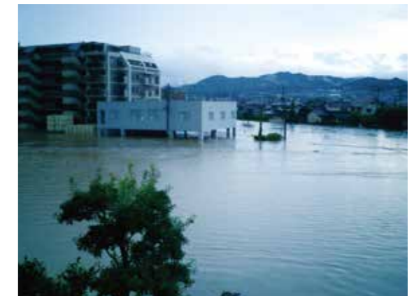
浸水する通古賀の落合橋周辺
