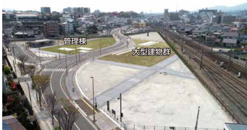
客館跡 (北西から)
