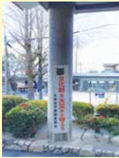
立看板の設置
