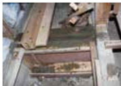
基礎の追加施工の一例
