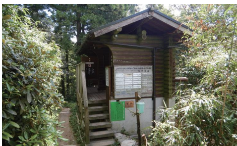
写真 3-20 バイオトイレ
