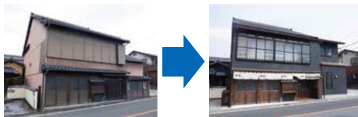
連歌屋好古亭保存修理前・後
