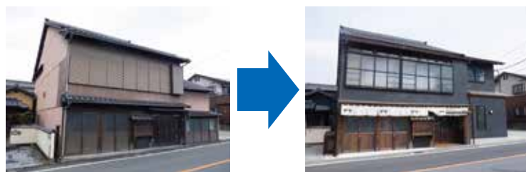
連歌屋好古亭保存修理前・後
