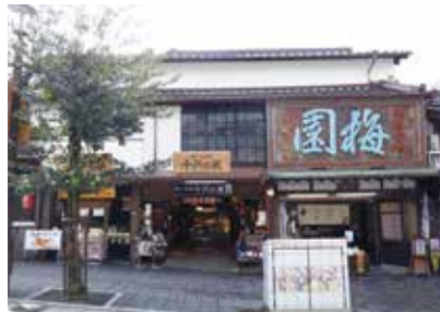
歴史的風致形成建造物の修理
