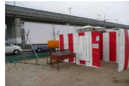
臨時トイレ（通古賀土地区区画整理事業用地）
