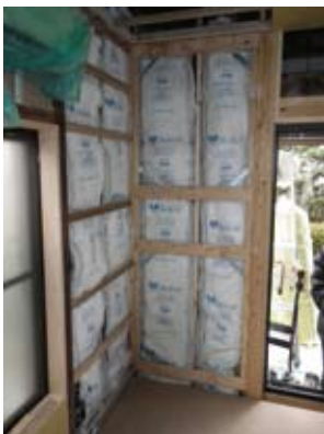
壁補強施工の例
