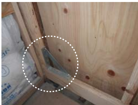
補強金具施工の例
