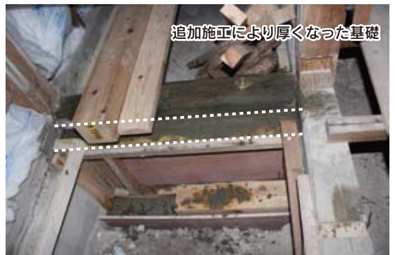
基礎の追加施工
